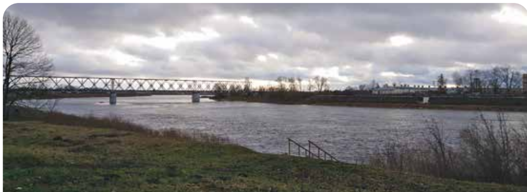
Widok ogólny na Dźwinę i most kolejowy, po którym poruszał się pociąg pancerny czerwonooarmistów, blokując przeprawę co skutkowało decyzją o oskrzydleniu Dyneburga łukiem od wschodu.
