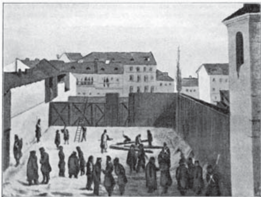
Nr. 141. Przechadzka więźniów na dziedzińcu więziennym we Lwowie.
