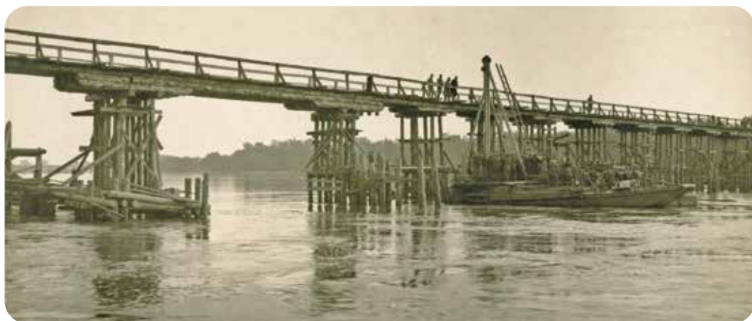
Budowa mostu Etapowego na Wiśle. Postawione wówczas pale wbite w koryto rzeki przetrwały do dzisiaj w postaci szczątkowej i są widoczne przy niższym stanie rzeki.
