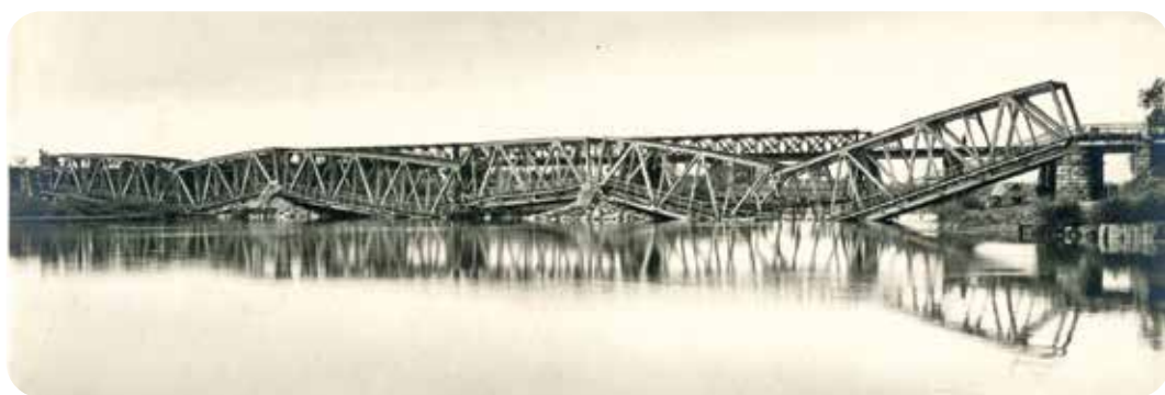
Wysadzony most kolejowy na Wieprzu i ustawiona za nim tymczasowa przeprawa kolejowa
