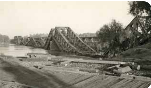
Wysadzony most kolejowy na Wiśle z widoczną na drugim planie prowizoryczną przeprawą kolejową
