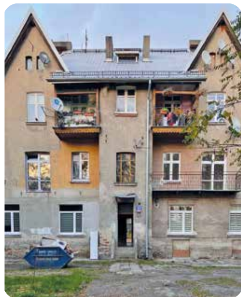
Budynek należący przed wojną do łódzkiego piwowara Gustawa Keilicha. Wykorzystywany był w celach rekreacyjnych. Obecnie dom czynszowy. Dawna siedziba komendantury Stalagu.
