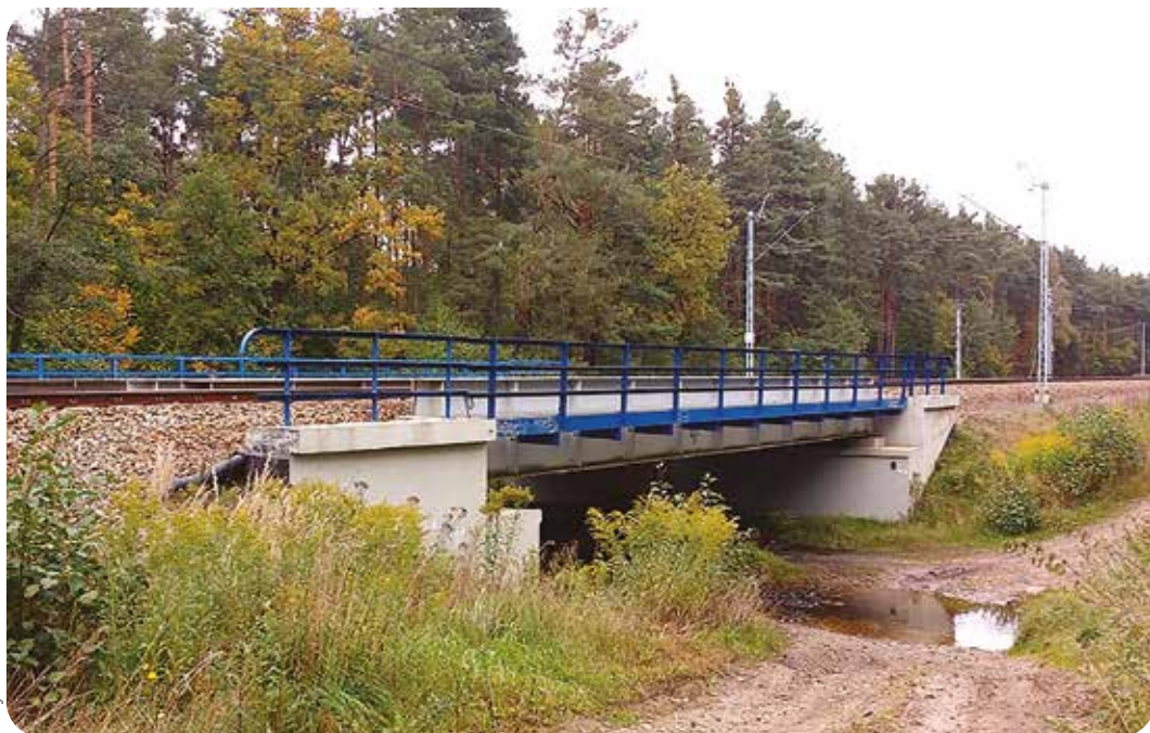
Most kolejowy w Jaktorowie na rzece Pisia, 2021 r.
