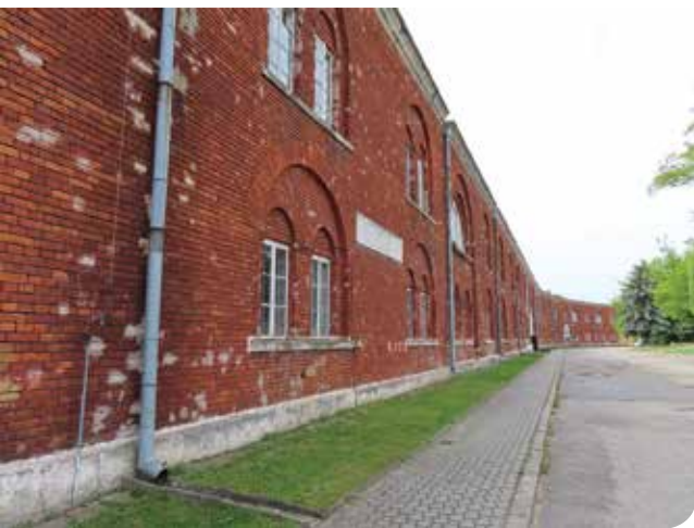
Budynek koszarowo-magazynowy w jego części południowej widziany od strony placu bronii
