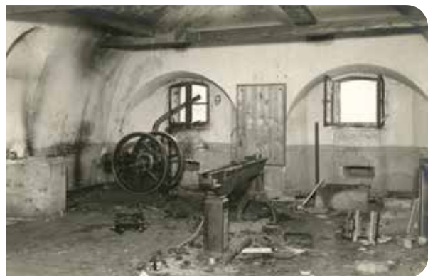
Zniszczone pomieszczenie przepompowni znajdujące się w kaponierze na prawym barku cytadeli
