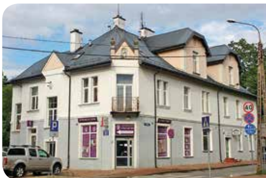
Dom Kalksteina, Milanówek, ul. Warszawska 21, 2022 r.
