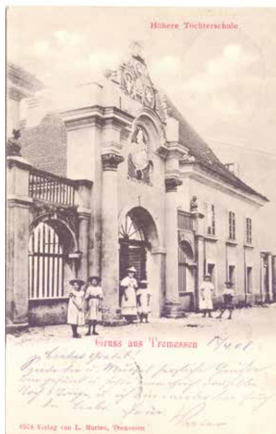
Budynek Alumnatu w Trzemesznie (zał. 1776)
