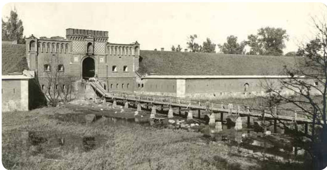
Brama Mikołajewska, obecnie Brama Lubelska Cytadeli Dęblinskiej. Na zdjęciu widoczna prowizoryczna kładka wykonana w celu zapewnienia komunikacji z Cytadelą.
