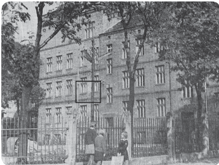
Budynek gimnazjum, w którym mieścił się szpital urządzony przez Niemców w pierwszych dniach okupacji Żyrardowa, również dla jeńców wojennych. Zaznaczone zostały okna pokoju woźnego gimnazjum.
