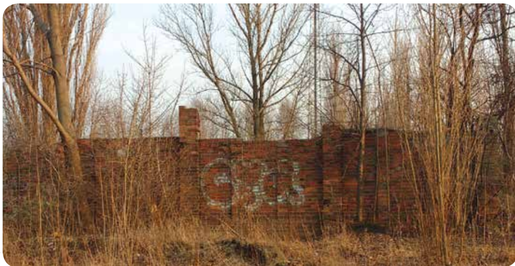
Resztki muru „Tytoniówki” widoczne od rampy – platformy kolejowej, 2022 r.
