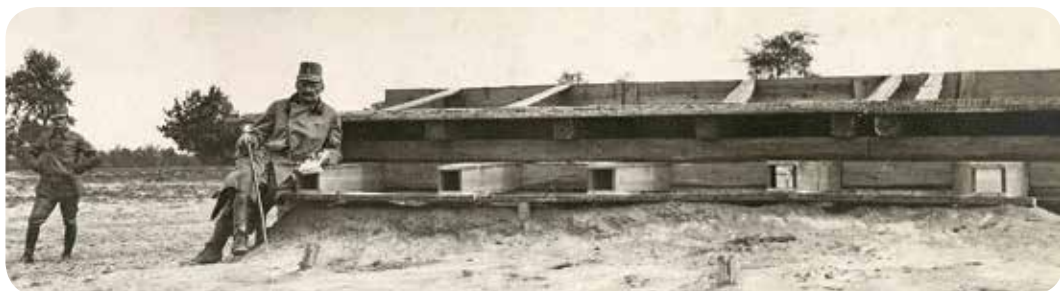
Zakryte strzelnice piechoty pod Stężycą, przy których sfotografowali się austriaccy oficerowie. Uwagę zwraca staranność wykonania strzelnic chroniących rosyjskich strzelców przed ostrzałem z broni powtarzalnej i kulami szrapnelowymi.
