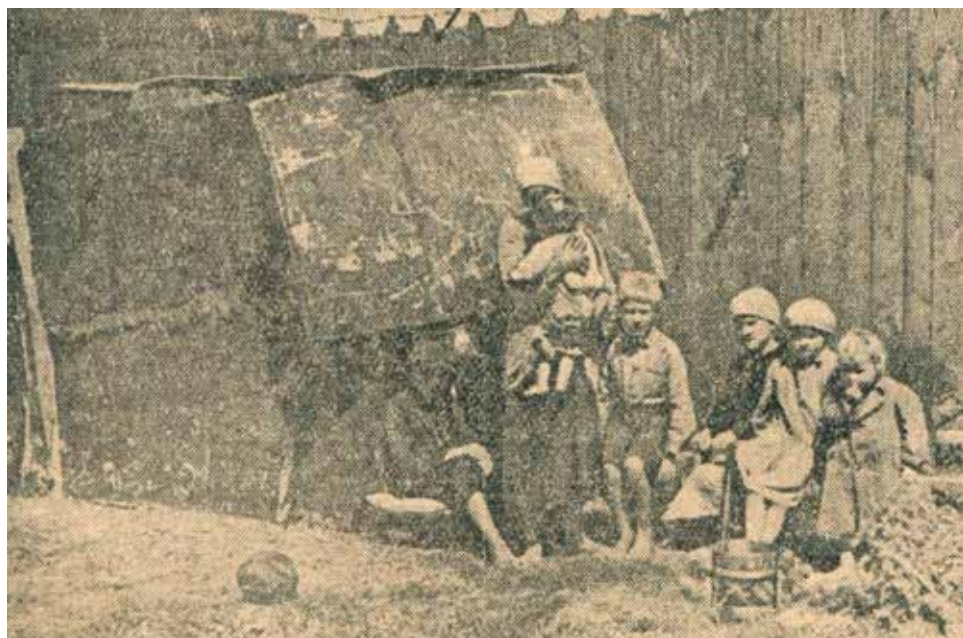
16. Widok domu przy ul. Tykocińskiej, „zredukowanego sekwestratora Salla- sa, poszukującego od półtora roku pracy. Posiada on żonę i 7 dzieci, z których najstarsze ma lat 12, a najmłodsze – rok”
