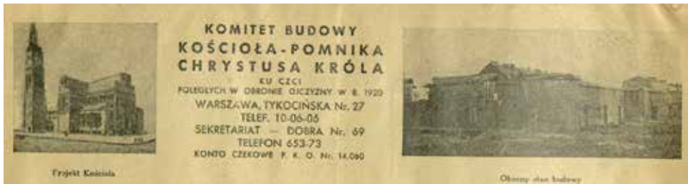
12. Projekt kościoła i stan budowy
