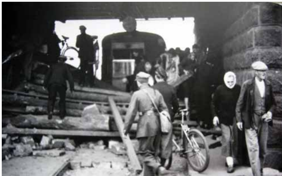
25. Wrzesień 1939, po bombardowaniu tunelu łączącego Targówek z Pragą – obecnie wiadukt przy rondzie Żaba
