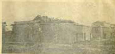
Obecny stan kościoła
