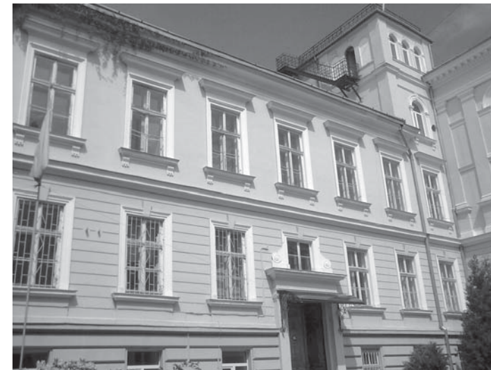
Il. 4. Fragment elewacji frontowej budynku uniwersyteckiego przy ul. św. Cyryla i Metodego. Źródło: fot. P. Brzegowego z 2016 r.
