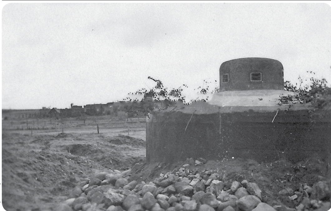
Na odcinku „Osowiec” zaplanowano budowę 52 schronów.
