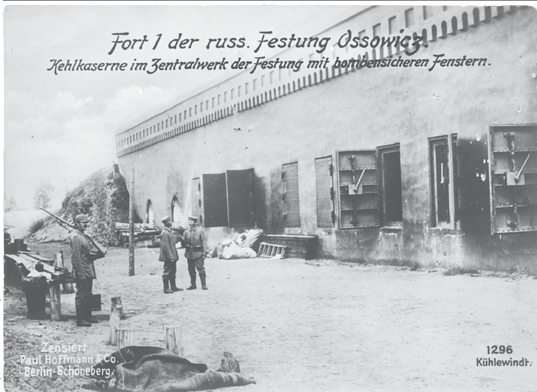
Fort I twierdzy Osowiec, budynek koszarowy z widocznymi otwartymi pancernymi okiennicami przeciwbombowymi. Poczłówka z lat 1915–1916
