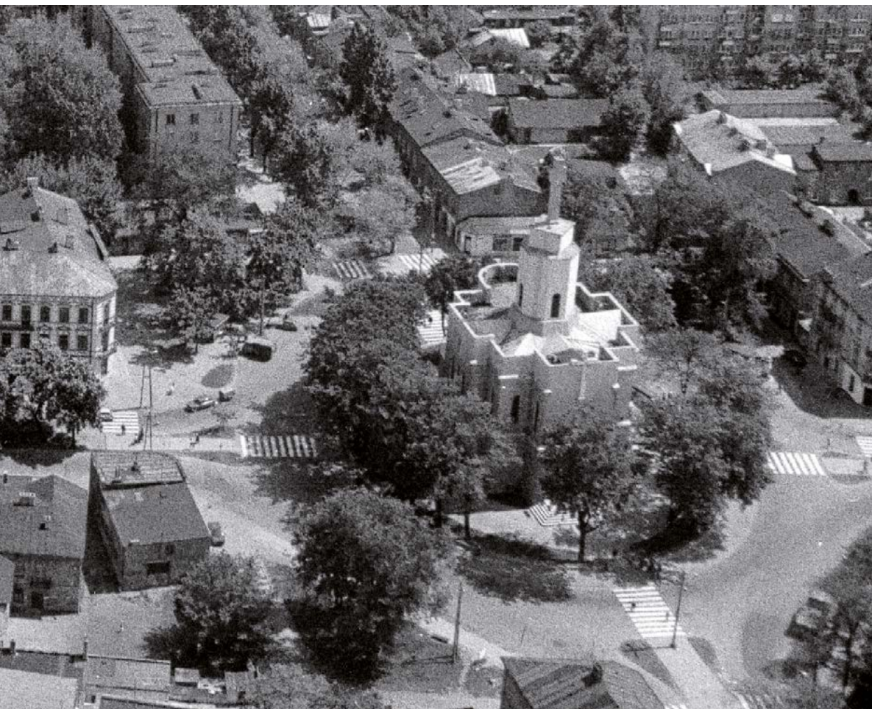
Kościół garnizonowy z lotu ptaka, widoczne relikty cerkwi w postaci dachów osłoniętych parawanem ścian po przebudowie. Fot. A. Ruciński, 1992 r.
