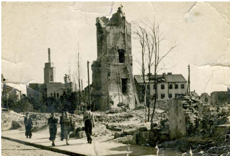
Końcówka prac rozbiórkowych wieży
