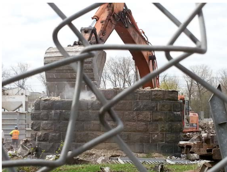
Ostatnie chwile ostatniego filaru kładki. Fot. S. Kordaczuk, 22 IV 2015 r.
