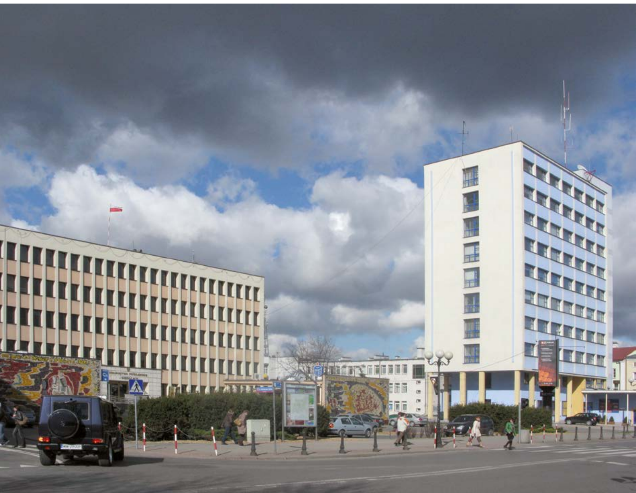
Spalony budynek Zarządu Żydowskiej Gminy Wyznaniowej. Za nim widać pomnik Niepodległości. Fot. Jerzy Urban
