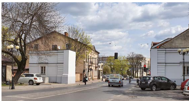
Pozostałości bramy po remoncie. Fot. S. Kordaczuk, 4 V 2020 r.
