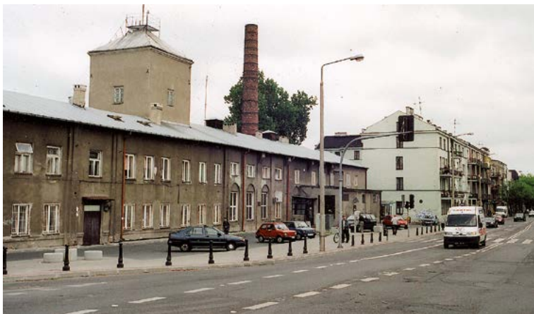
Widok z wiaduktu Warszawskiego na Polską Grupę Energetyczną przy ul. Piłsudskiego 100/102 jeszcze z kominem świadczącym o przeszłości tego kompleksu jako Elektrowni Miejskiej.
