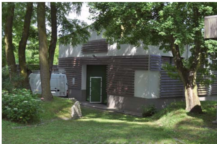
Ryc. 6. Budynek główny Pracowni Konserwacji Drewna Archeologicznego na terenie Ośrodka Magazynowo-studyjnego PMA w Rybnice k/ Sochaczewa. Fot. W. Borkowski.
