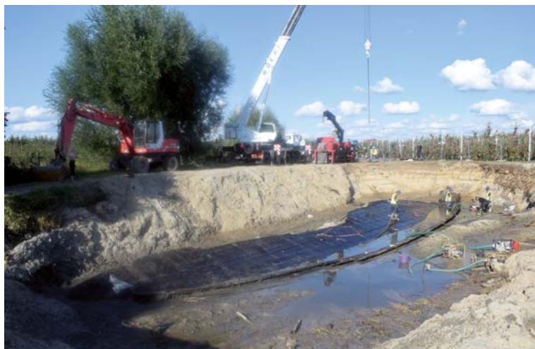
Ryc. 20. Część denna statku przygotowana do wydobycia i transportu do Ośrodka PMA w Rybnie. Fot. M. Paczkowski.
