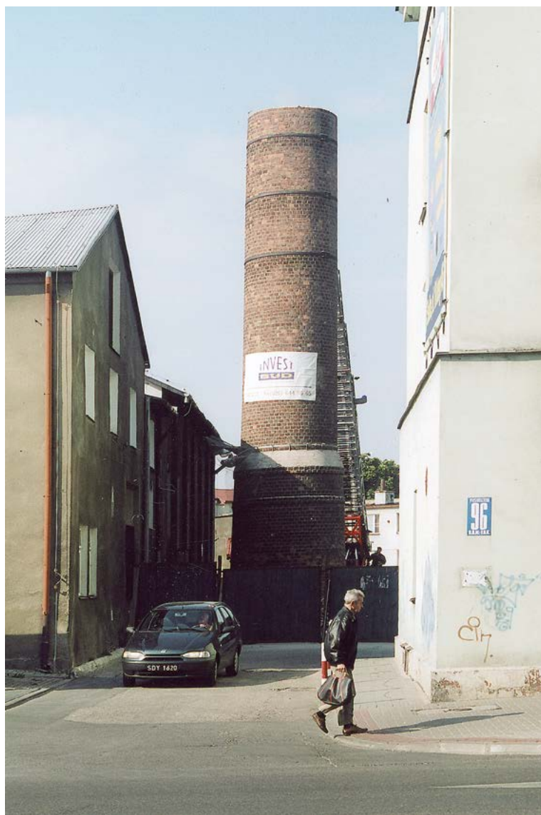
Ostatnie dni rozbieranego komina elektrowni. Fot. S. Kordaczuk, 29 VIII 2003 r.
