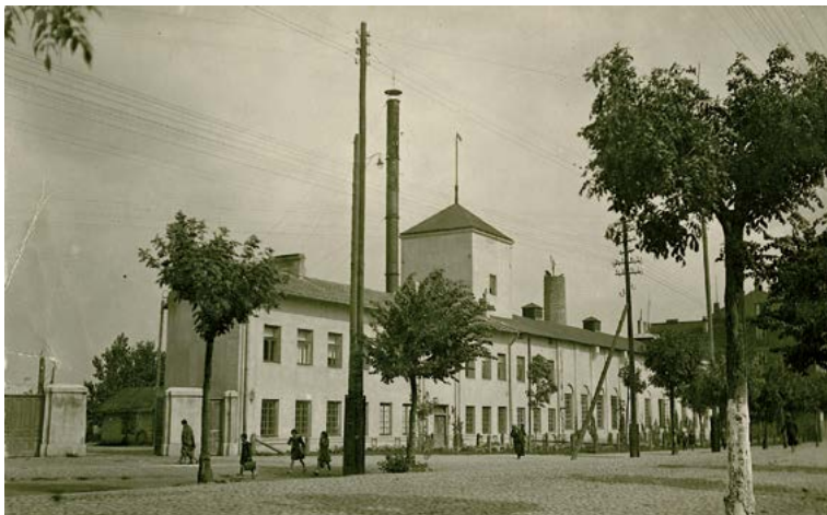
Elektrownia Miejska na końcu ul. Piłsudskiego. Fotografia wykonana w 1933 r., w czasie rozbudowy zakładu i zwiększenia mocy, w końcowym etapie murowania komina z cegły.
