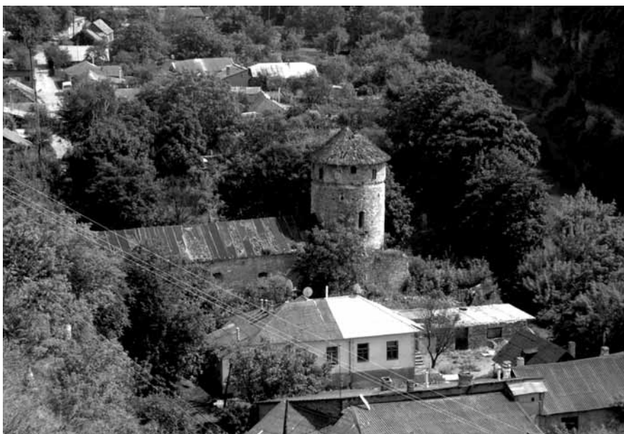
Widok ogólny na Bramę Ruską – widać jedynie część tego obiektu, a mianowicie Basztę Przybrzeżną i kazamaty – stan z 2008 r. Fot. A. Smoliński
