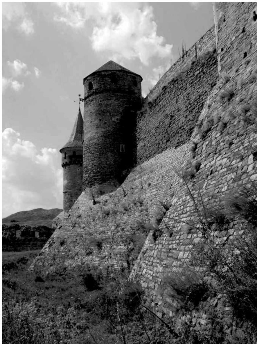
Południowa część Starego Zamku. Dobrze widoczna jest Baszta Kołpak oraz fragment stojącej za nią Baszty Tęczyńskiego – stan obecny. Fot. A. Smoliński
