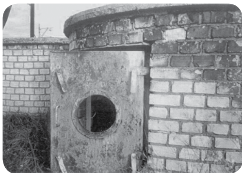
Hermetyczne drzwi do bani gazowej
