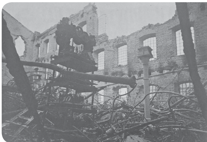
Zniszczona hala maszyn Fabryki Wrobów Gumowych przy ul. Grochowskiej 274/276
