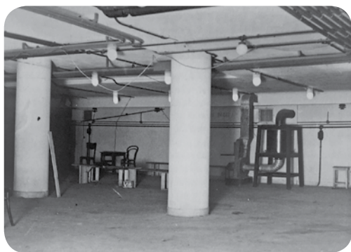
Wnętrze schronu pod budynkiem PKO
