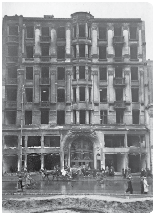
Wypalona sylwetka 7-piętrowego domu handlowego przy ul. Senatorskiej ostała się dzięki żelbetowym stropom
