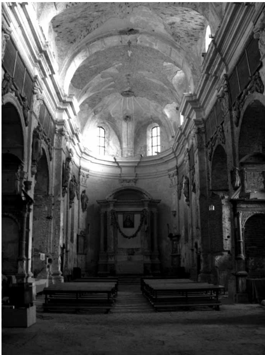
Zniszczone wnętrze prezbiterium, nawy głównej i ołtarzy bocznych, kolegiaty. Fot. Aleksander Smoliński, lipiec 2006 r.
