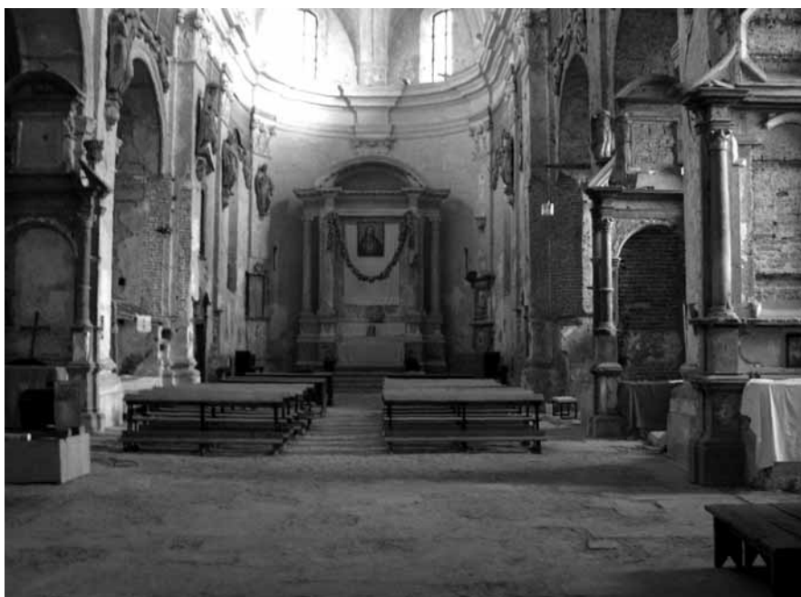
Zdewastowane prezbiterium i część nawy głównej ołyckiej kolegiaty. Fot. Aleksander Smoliński, lipiec 2006 r.
