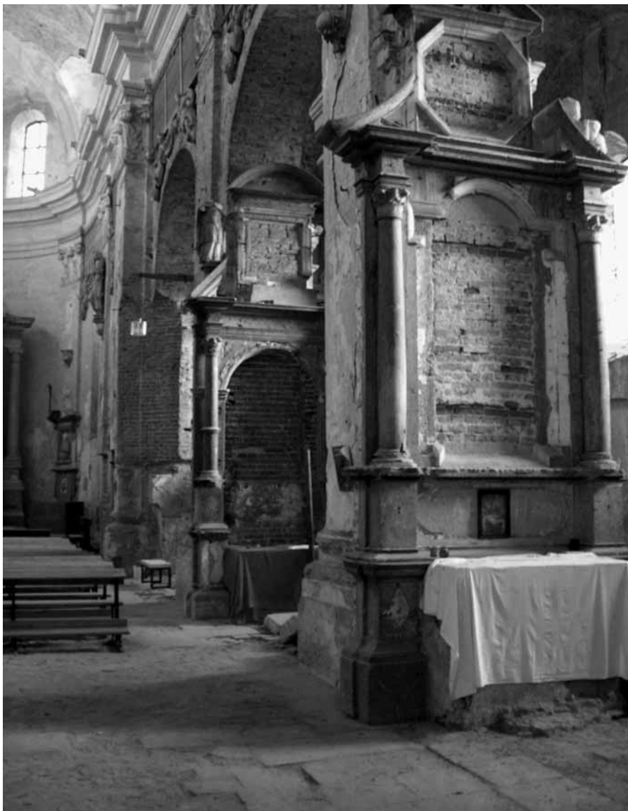
Zniszczone ołtarze boczne oraz nagrobki w kolegiacie. Fot. Aleksander Smoliński, lipiec 2006 r.
