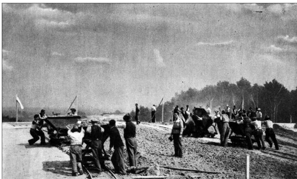
Fragment budowy Kopca Józefa Piłsudskiego. Robocza brygada przy pracy.
