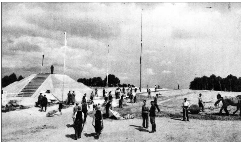
Fragment budowy Kopca Józefa Piłsudskiego. Robocza brygada przy pracy.
