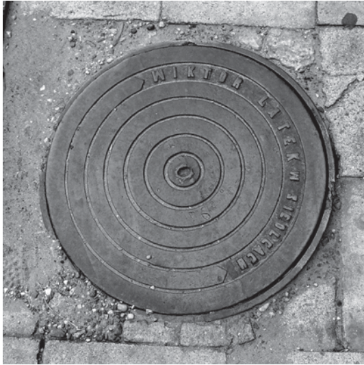
Właz do studzienki kanalizacyjnej odlewni Wiktora Łatka w chodniku ul. Floriańskiej w Siedlcach (obecnie w zbiorach MRS/H/275). Fot. Sławomir Kordaczuk, 18 VI 1998 r., neg. 108/27
